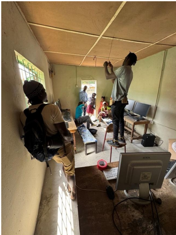
Abbildung 9 – Montage der Deckenlampen
